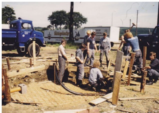
Erste Arbeiten zum Dorfbrunnen auf dem Dorfplatz
