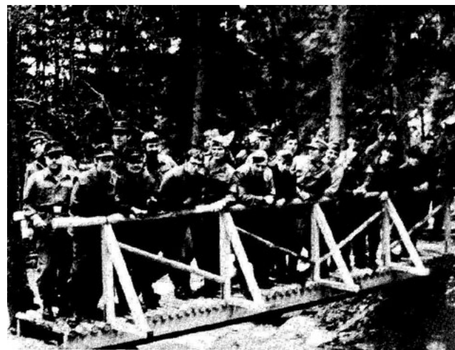
Belastungsprobe der Brücke über den Kelzerbach
